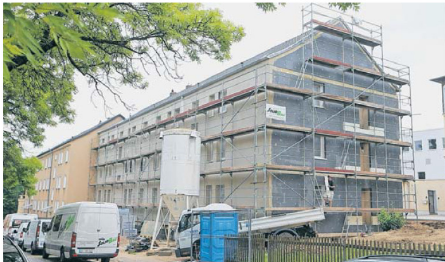
An der Jahnstraße 18/18a in Glauchau laufen die Modernisierungsarbeiten auf vollen Touren. FOTO: ANDREAS KRETSCHEL
